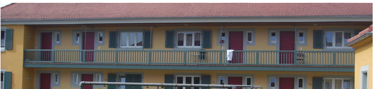
Saniertes Haus im Laubenhof
